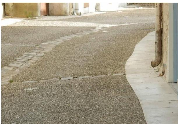
Lors d'aménagement par sols en béton ou lors d'usage de l'enrobé (chaussées à fort trafic ou gestion courante de l'existant), il importe de ne pas mettre le béton ou l'enrobé en contact direct avec les pieds de façades.
