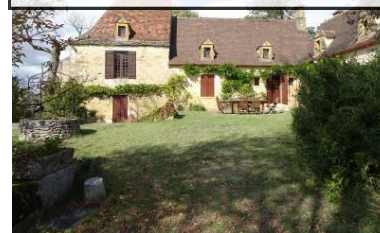
Fages. Rangs de lauzes conservés en toiture.
