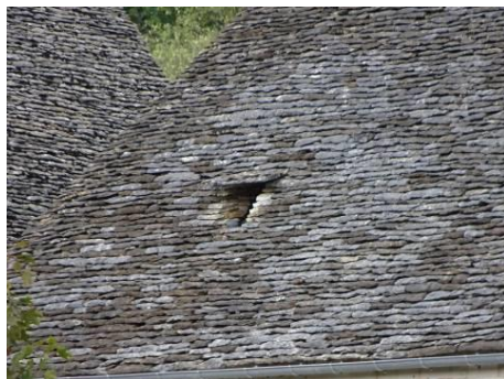
Bagneroles. Outeau rectangulaire dans un toit en lauzes.
