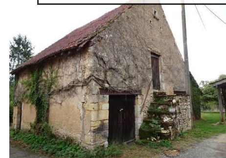
Le Faux. Grange-étable avec escalier extérieur.
