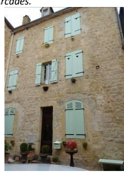
Rue des Remparts. 19 e siècle.
