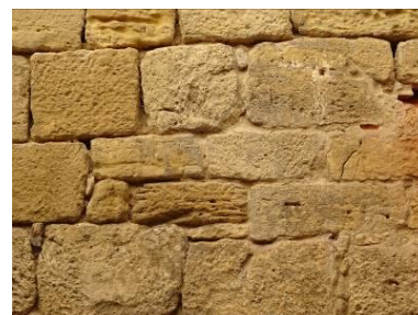
Impasse des Oies. Blocs de calcaire soigneusement équarris. 15 e siècle.
