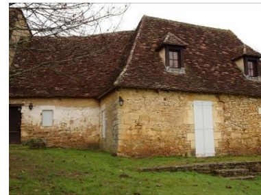
Couverture en tuile plate au Vézat.
