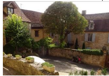
Place du Terme. Couverture de lauzes.
