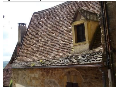
Rue Bertrand de Got. Lauzes et tuiles plates.
