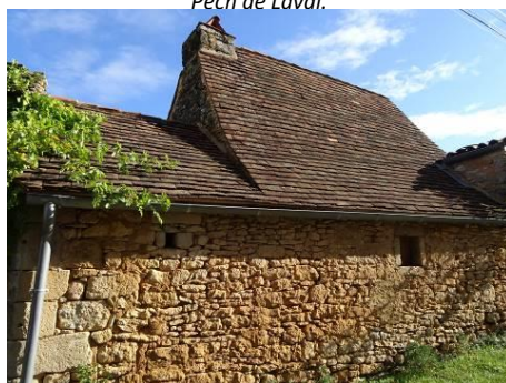
Péchalifour. Four de plan rectangulaire sous toiture à deux pans.
