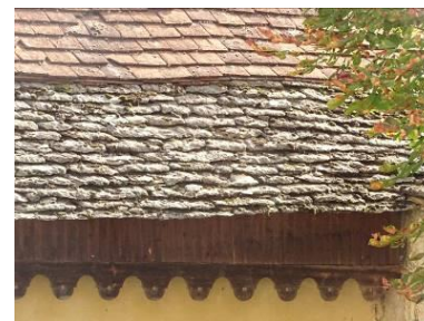
Rue du Terme. Couverture de lauzes.
