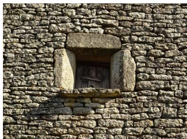
Capudie. Moellons calcaires. Pignon d'une dépendance agricole.
