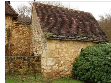
Couverture de lauzes partiellement conservée au Vézat.
