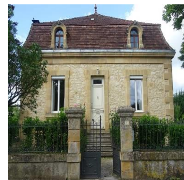
Avenue de la Gare. 19 e siècle. Parement en moellons destiné à recevoir un enduit.
