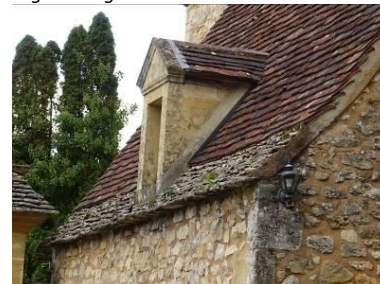
La Manorie. Couverture en lauzes et tuiles plates.
