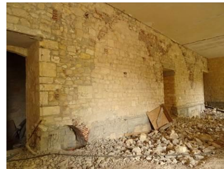
Aile ouest du cloître, rez-de-chaussée conservant les traces de voûtes gothiques en rez-de-chaussée.
