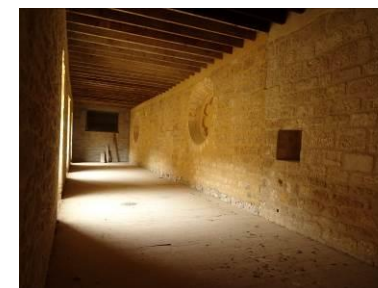
Partie haute du mur gouttereau nord de la nef vue depuis l'aile sud du cloître remaniée et surélevée au 17 e siècle. De grands oculi trilobés assuraient du 13 e siècle au 17 e siècle l'éclairage de la nef.
