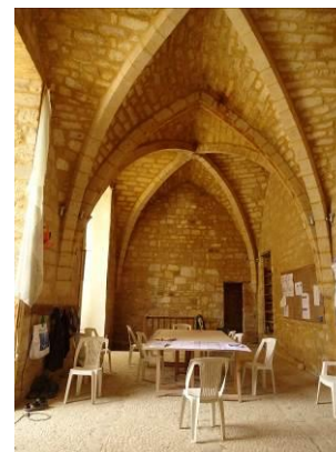
Aile ouest, rez-de-chaussée, grande salle voûtée.
