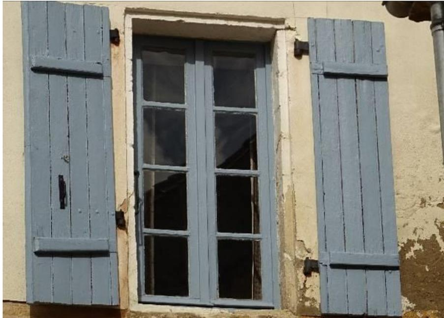
La fenêtre est traditionnellement en bois, un matériau durable, car réparable et adaptable. Le découpage des vitrages en carreaux par des petits bois mortaisés participe du dessin de la façade.
