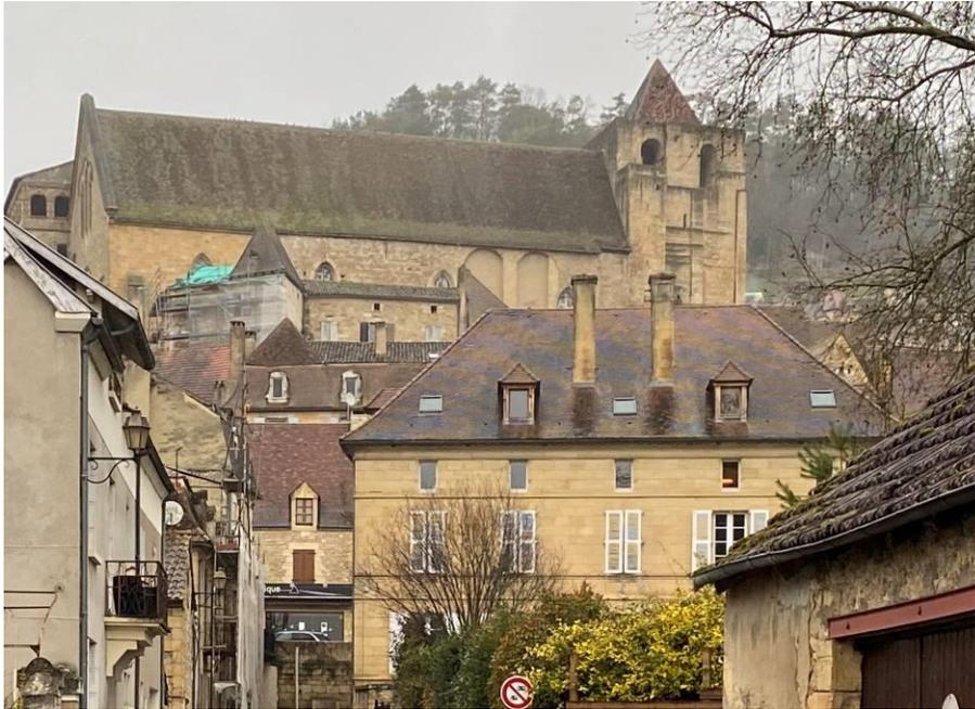
La tuile plate est mise en œuvre sur une toiture à forte pente (entre 100 et 150%). Elle est de petit format, d'où une grande quantité d'éléments par mètre carré (de 60 à 70).
