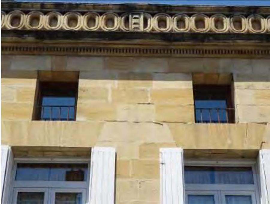
Le mur est monté d'assises régulières de pierres de taille à arêtes vives et avec des joints fins. L'appareil est assisé et réglé. La pierre est dite dressée lorsqu'elle est taillée pour obtenir des surfaces planes.
