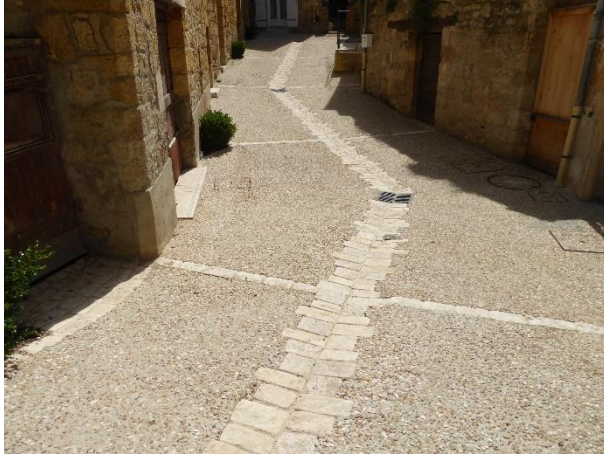
Le système d'évacuation des eaux pluviales est ici traité par la mise en œuvre d'un caniveau en pierre
