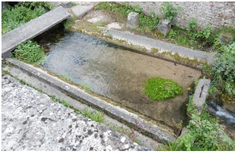
Lavoir. Rue de la Grange des Pères.
