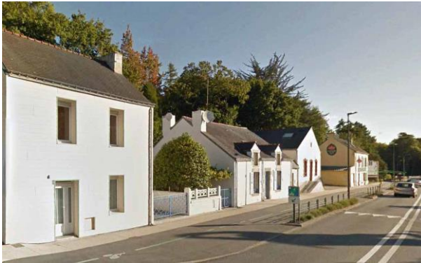
Le revêtement par l'extérieur efface les éléments d'architecture qui caractérisent le patrimoine et sa qualité, voire qui contribuent au pittoresque.
