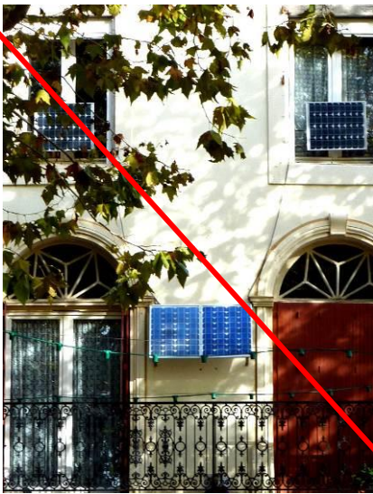
Il ne faut pas apposer sur les façades des installations techniques qui en brisent l'harmonie
