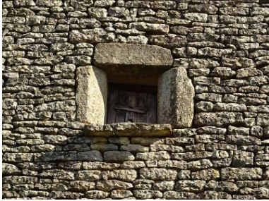
Capudie. Moellons calcaires. Pignon d'une dépendance agricole
