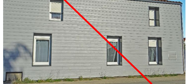
La même maison, après isolation par l'extérieur.
