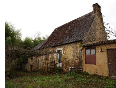
Petite maison du 18 e siècle avec fond d'une niche d'évier en façade.
