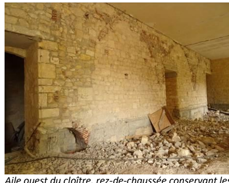
Aile ouest du cloître, rez-de-chaussée conservant les traces de voûtes gothiques en rez-de-chaussée.
