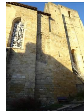
A droite, mur gouttereau de la nef intégrant une porte en arc brisée à arête vive (12 e siècle – début 13 e siècle ?). Au centre, raccord de la nef sur le clocher-tour. En partie basse, pierre de taille sculptée de quatre rocs d'échiquiers.
