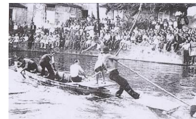
L'étang (le bief) du moulin du Prieur en 1963 avant d'être busé.
