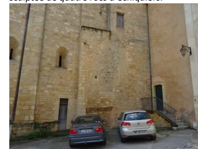
Extrémité est du mur gouttereau de la nef conservant les vestiges des voûtes de la galerie sud du cloître.
