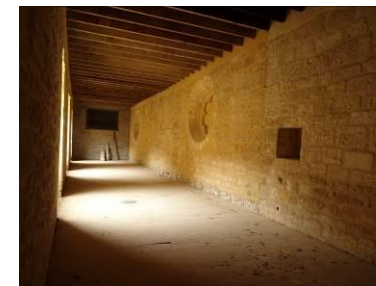
Partie haute du mur gouttereau nord de la nef depuis l'aile sud du cloître remaniée et surélevée au 17 e siècle. De grands oculi trilobés assuraient du 13 e siècle au 17 e siècle l'éclairage de la nef.
