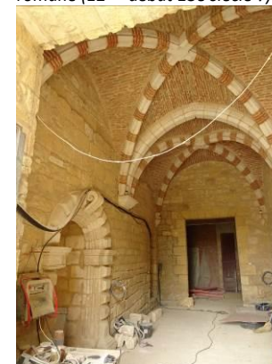
Aile ouest, rez-de-chaussée, passage voûté du 17 e siècle.
